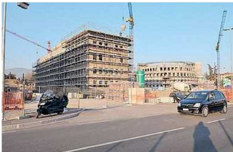
NUOVA QUESTURA Il palazzo, quasi ultimato, si affaccia su via Pertini, a Porta Nuova Foto di Luca Castellani
